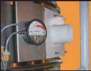
Anzeigegerät misst Filterwiderstand
