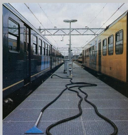
Nassreinigung von Eisenbahnwaggons. Die Saugrohrleitung und die Anschlussventile für die Saugschläuche sind unter der Plattform montiert.
